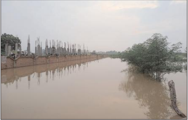
जताई जा रही है। स्थानीय स्तर से मिली जानकारी के अनुसार, बाढ़ का पानी निर्माण स्थल के विभिन्न हिस्सों में फैल गया है। तेज बहाव
